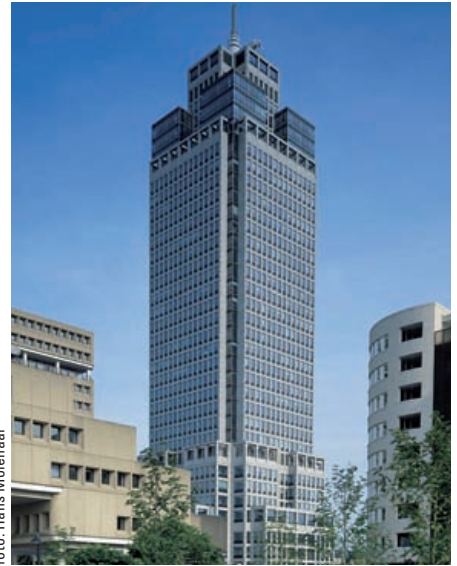
Staalskelet en staalplaat-betonvloeren economisch door laag eigengewicht en bouwsnelheid.
