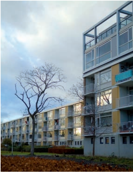
Lichte staalframebouw vloer maakt extra lagen mogelijk.
