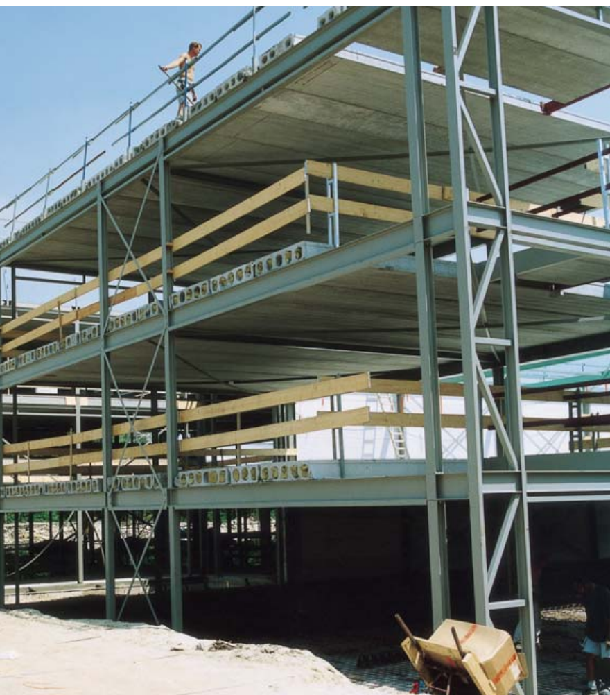
De stabiliteitsjukken zijn in hun geheel gelast in het staalconstructiebedrijf, inclusief een stuk gevelligger.
