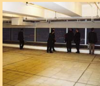
Interieur Fire refuge floor
