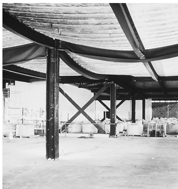
10. Ondanks de hoge en langdurige thermische belasting is de staalconstructie niet bezwaken.
