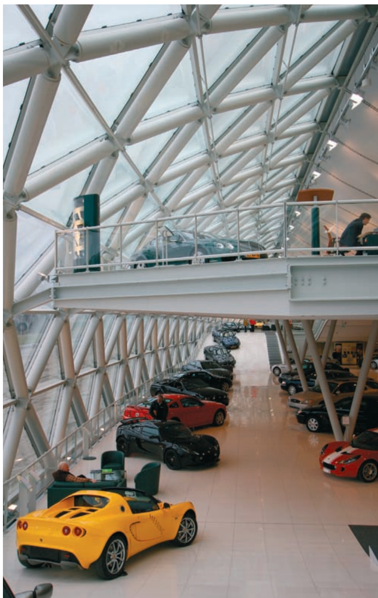
Onder de horizontale kokerprofielen loopt een sprinklerinstallatie.
