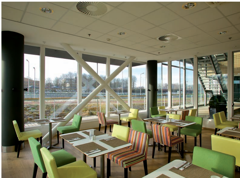
De begane grond heeft betonkolommen met daarop de staalconstructie van de kamers.
