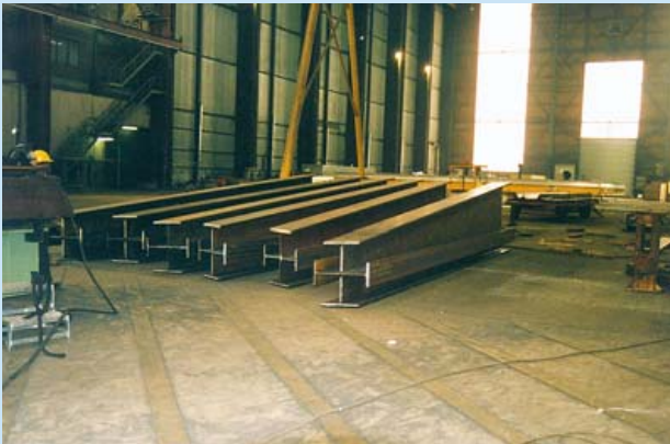
De fabricage van de kolommen.
