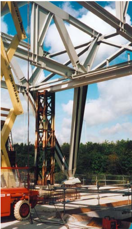
Aansluiting van de tafelpoot op het tafelblad.
