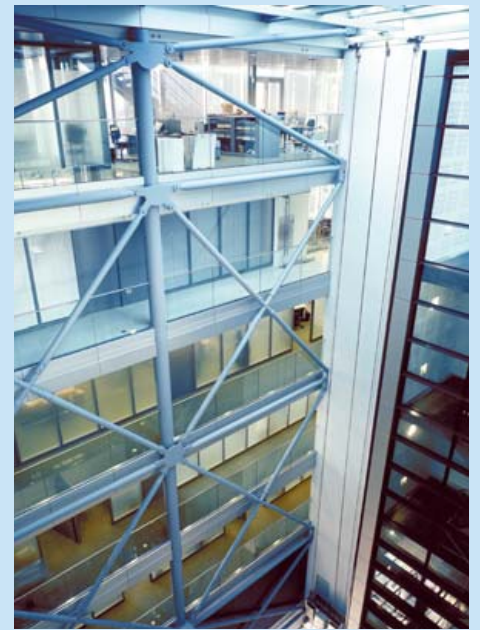
Aanzicht verband in vide, evenwijdig as B tussen as 10 en 12. De stabiliteitsverbanden die in het zicht zijn gebleven, kregen een behandeling met brandwerende verf.
