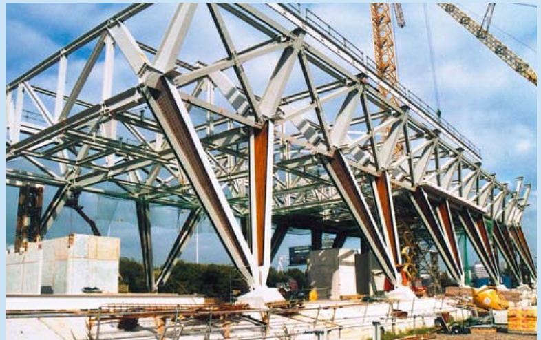
Het vakwerk in de langsrichting.
