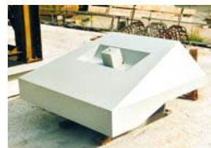
Bekisting van de voetplaat.
