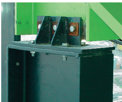
Net zo min als de gevelstijlen, dragen de drie HEA 700 profielen de zalen niet. Ze zijn aan de bovenzijde voorzien van verticale slobgaten.
