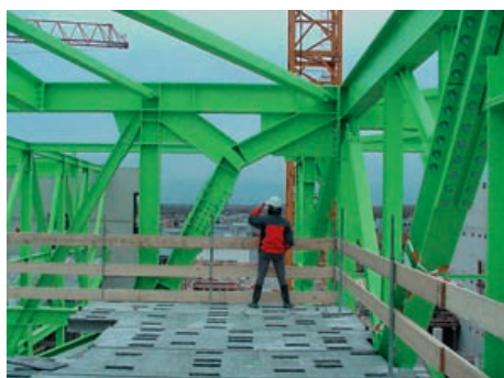
De diagonaal is omgetrokken om voldoende deursparing te verkrijgen.
