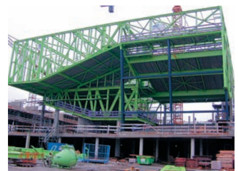
Vloeren en vakwerken in aanbouw.
