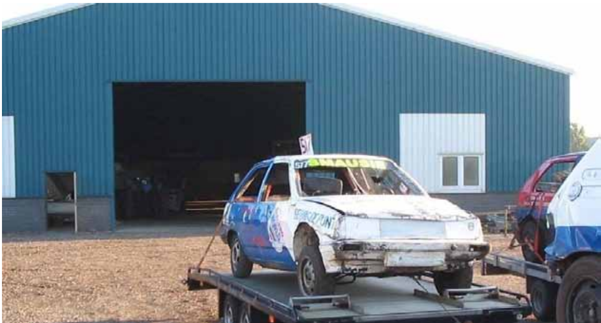
Foto 1 Voorgevel loods met geopende overheaddeur
