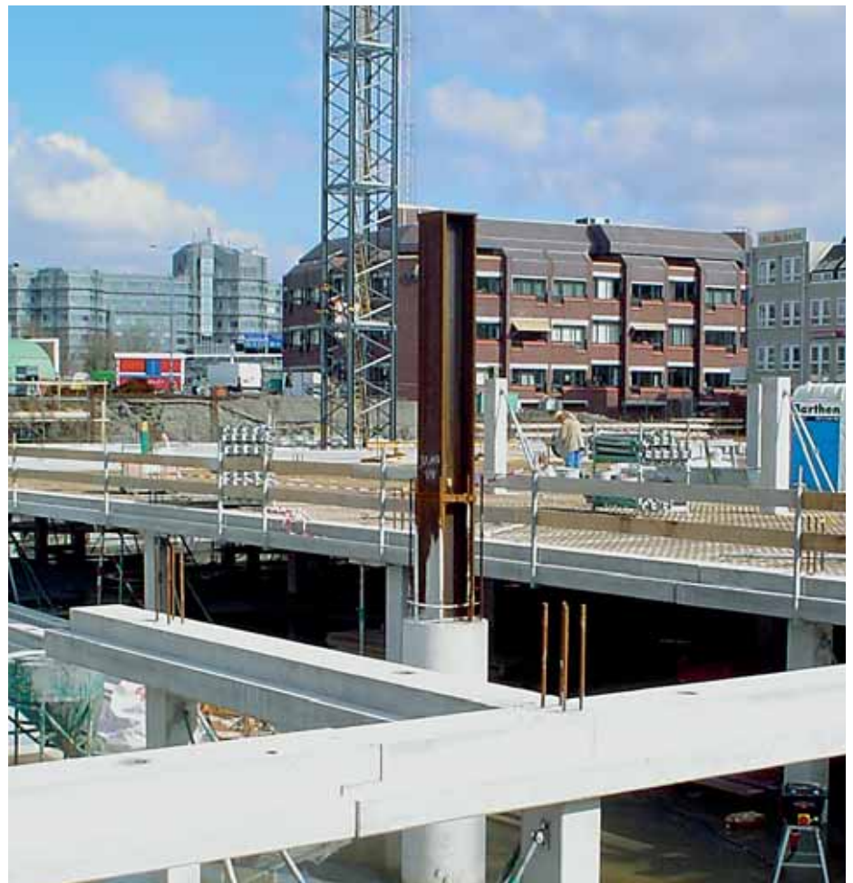
12. Volledig omstorte staal-beton kolom in het werk.
