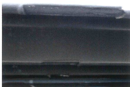
Inslijding coating door oplegging stophout (1).
