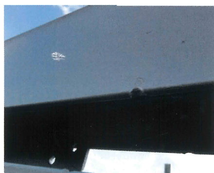
Inslijding door oplegging juk bij spuiten (kantelen).
