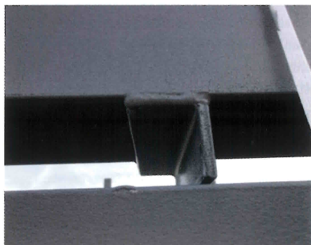
Overmaat coating door verschillende spuittrichtingen.
