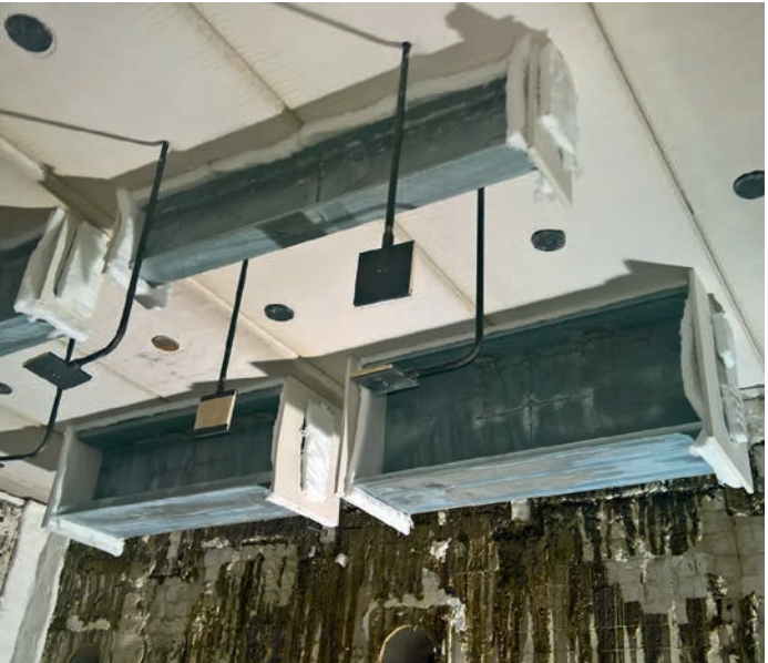
2. Proefstukken in de testen van CTICM-Galvazinc-EGGA, uitgevoerd bij Efectis Frankrijk [1] : liggertesten met driezijdige verhitting en kolomtesten (H-profielen en kokers) met vierzijdige verhitting [8] .
