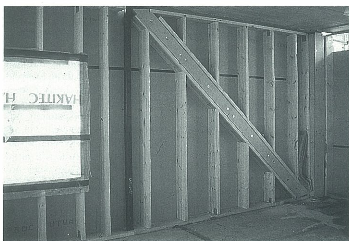
Een staalconstructie moet tegen brand bestand zijn. Als men de constructie op inventieve wijze beschermt, kan dat nagenoeg kosteloos. Een voorbeeld is de integratie van een stabiliteitsverband in de gevel.
