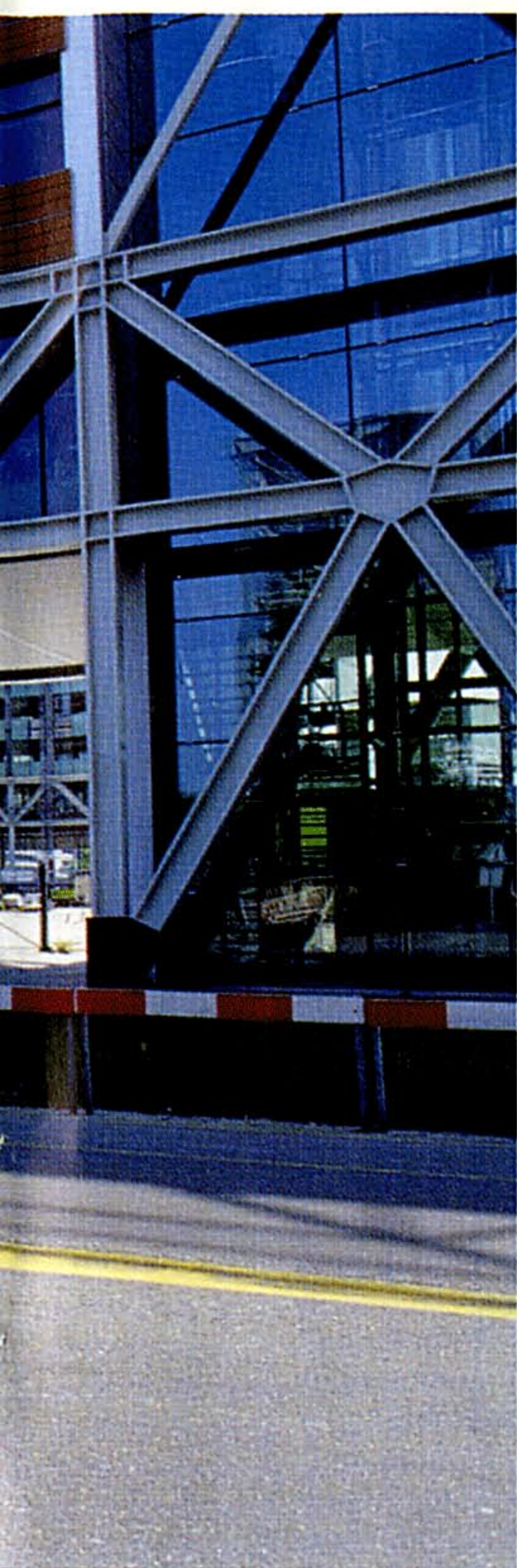
Op de voorgrond Bruggebouw West dat al enige tijd in gebruik is. Op de achtergrond is Bruggebouw Oost in aanbouw (zie ook kleine foto).
