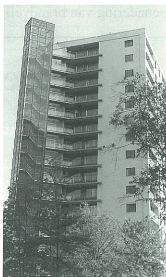
2. Vluchtwegen stellen de aanwezigen in staat het gebouw snel te verlaten. Het is zonder twijfel de meest doeltreffende manier om ongevallen door een eenmaal ontstane brand te voorkomen.
