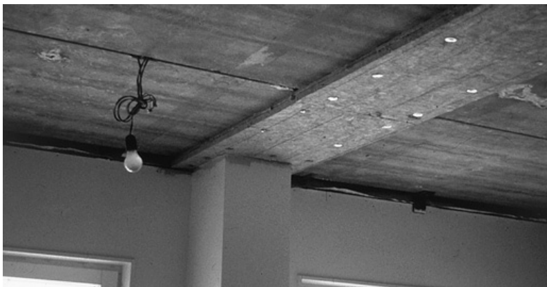
Bekleden van de onderflens van een geïntegreerde ligger met platen minerale wol.
