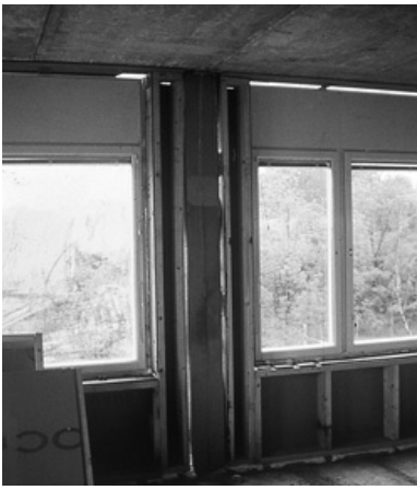
Bouwkundige integratie van een kolom in het binnenspouwblad).
