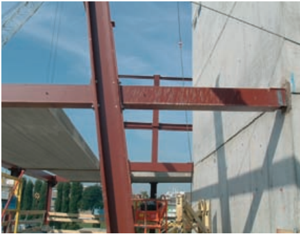
Aansluiting balk op stabiliteitskern.
