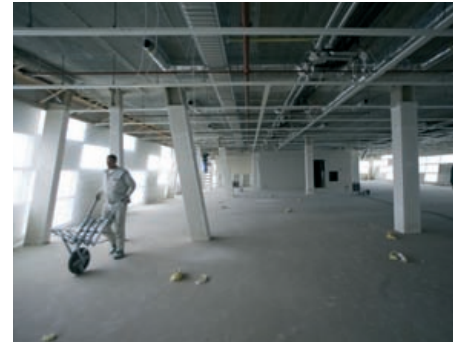
Kantoorvloer in afbouwfase.
