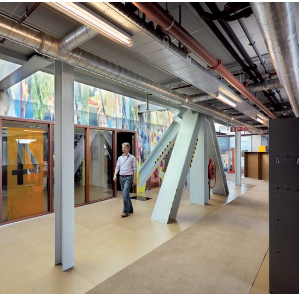
De compositie van de kolommen achter werd gedictieerd door de bestaande leidingbrug.
