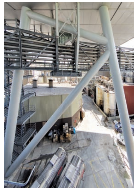
De compositie van de kolommen achter werd gedictieerd door de bestaande leidingbrug.
