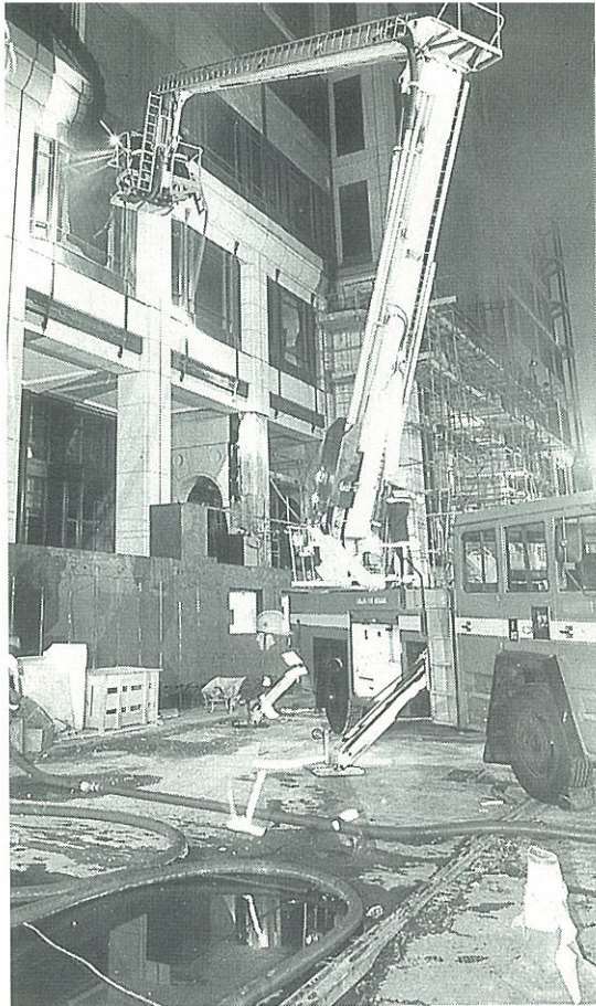
Afbeelding 2. De brandweer in actie vanaf een blusplatform ter hoogte van de eerste verdieping
