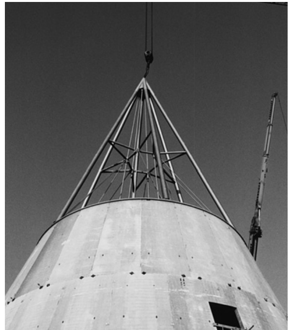
Staalconstructie van de top van de kegel.
