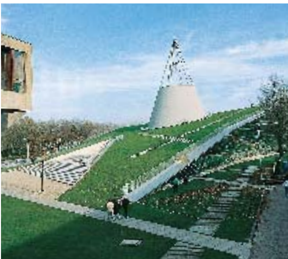
ir. H.G. Krijgsman en ir. W. Spangenberg ABT-West Adviesbureau voor Bouwtechniek, Delft
