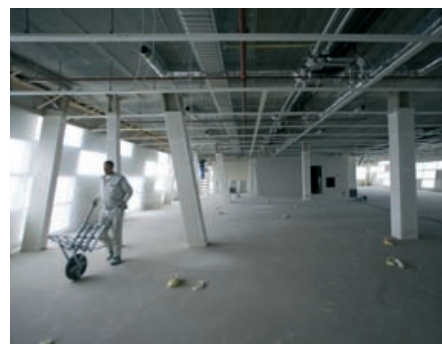
Kantoorvloer in afbouwfase.
