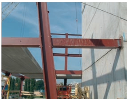
Aansluiting balk op stabiliteitskern.
