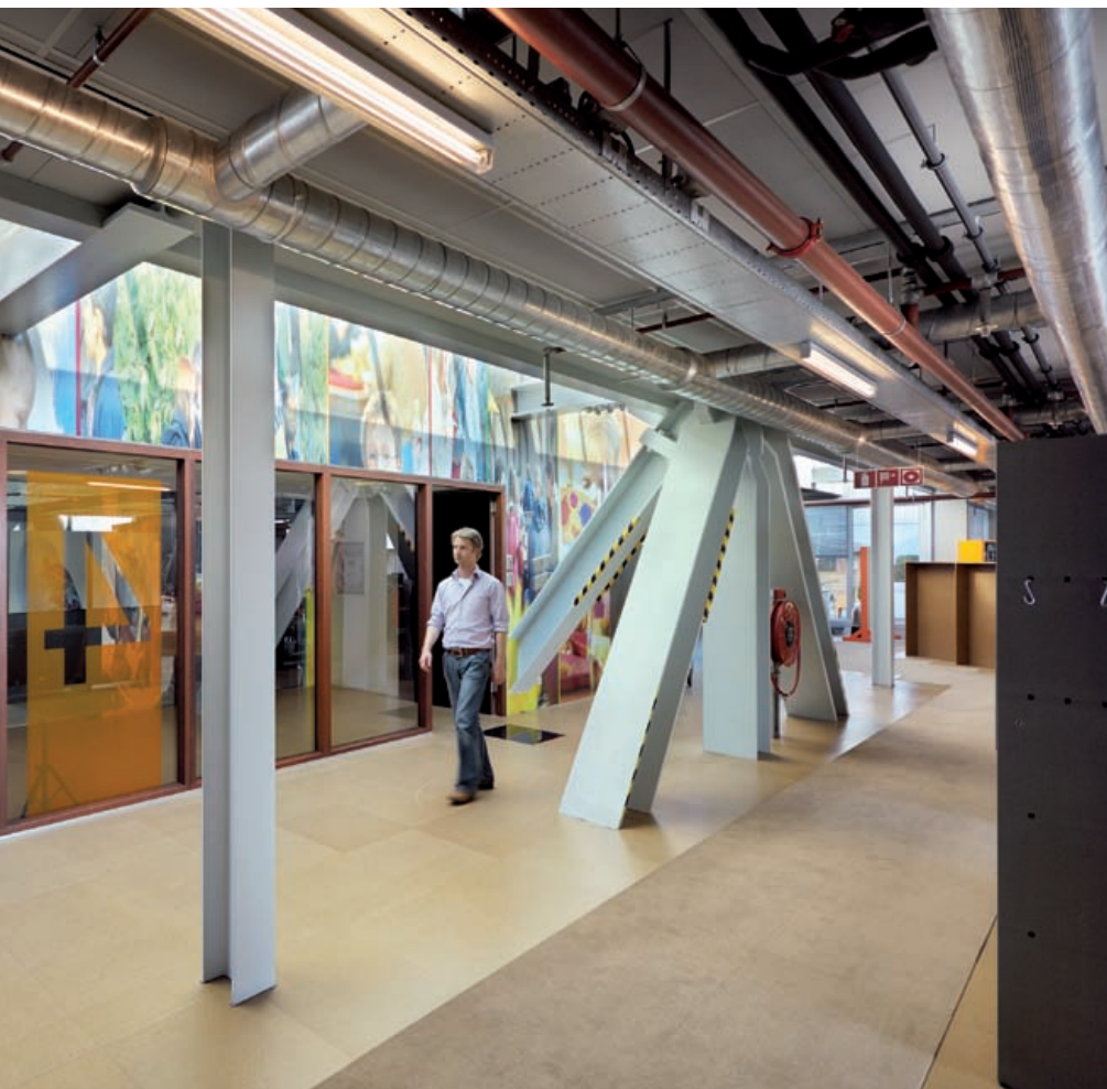
De compositie van de kolommen achter werd gedicteerd door de bestaande leidingbrug.
