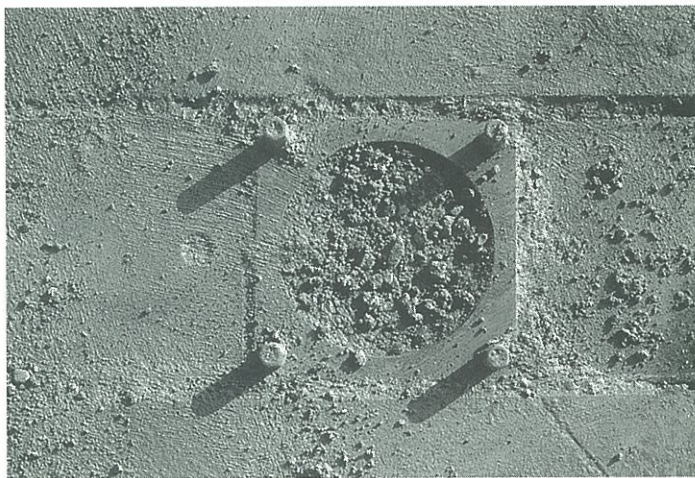
7. Bedrijfsgebouw Thermopol in Monster. De ongewapende buiskolommen worden van bovenaf gevuld (links) en bezitten een brandwerendheid van 60 minuten (rechts).
