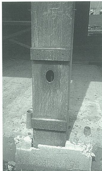
8. Kantoorgebouw Haagse Tram Maatschappij in Den Haag. Buiskolommen met wapeningkorven zijn over vier bouwlagen in één keer vanaf de begane grond met beton gevuld (foto: Voorbij Betonbouw, Wilnis).
