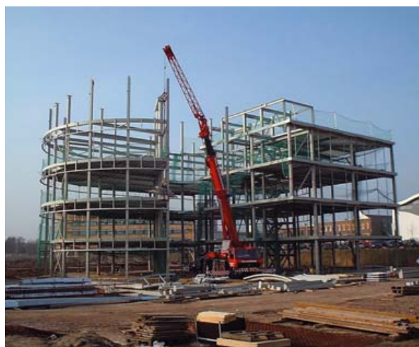
Het kantoorgebouw Da Vinci heeft een volledige draagconstructie van staal.
