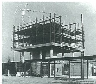
De bovenbouw staat op een zware betonnen 'tafelconstructie'.
