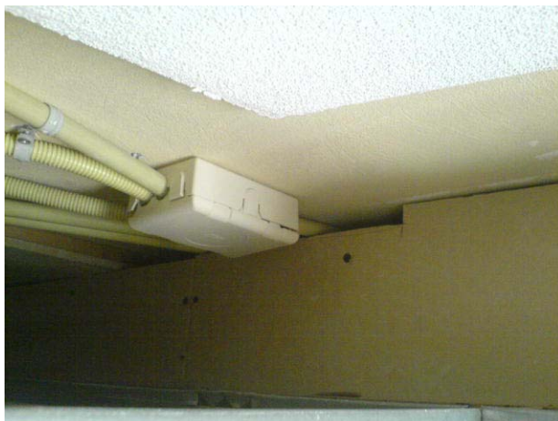
Foto 1: Wand is vanwege doorgetrokken leidingen niet meer 20 minuten brandwerend.
