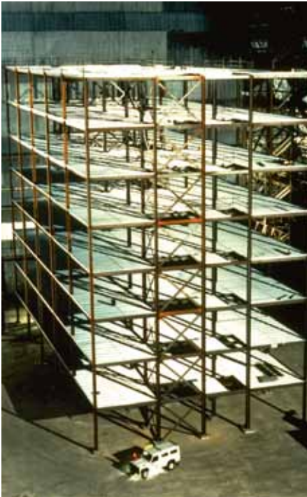
2. Cardington testgebouw vóór het betonstorten van de vloeren.
