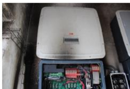
De kap van de linker omvormer verwijderd
