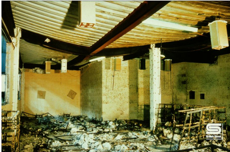
Vervormde toestand van het verhitte deel van de staal-betonvloer
