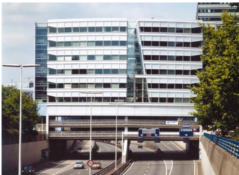
Kantoorgebouw Equinox Office in Den Haag: een modern kantoorgebouw met geïntegreerde liggers en kanaalplaatvloeren.
