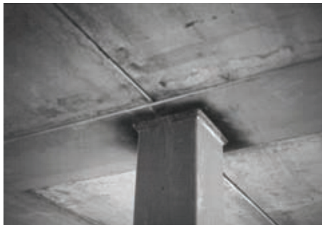
6.9. Verdieping-hoge stalen kolom in het werk gesteld en gelast aan een ligger.
