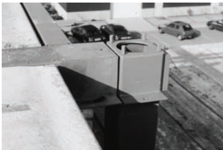
6.3. Kolom-liggerverbinding met kluit, pen en gat in het bedrijfsgebouw Termopol in Monster (1993).
