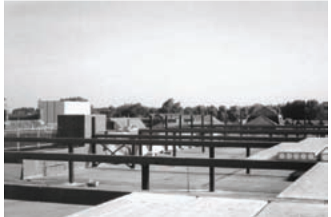
1.6. THQ-ligger (PPTH) in een parkeergarage, Purmerend (1992): (a) interieur; (b) montage.
