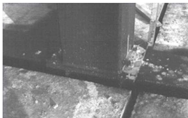
6.7. Verbinding tussen vloerligger en kolom (type 5b) in het kantoorgebouw van Unidek in Gemert (1994).
