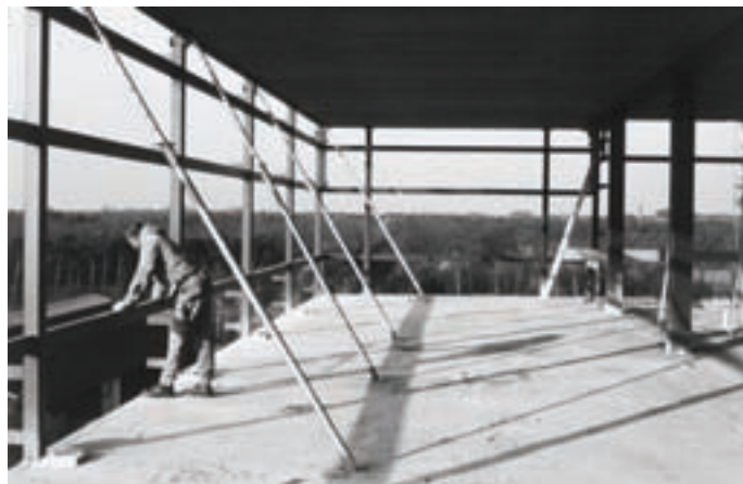
6.1. Afgeschoorde gevelkolommen in het kantoorgebouw van Unidek in Gemert (1994).
