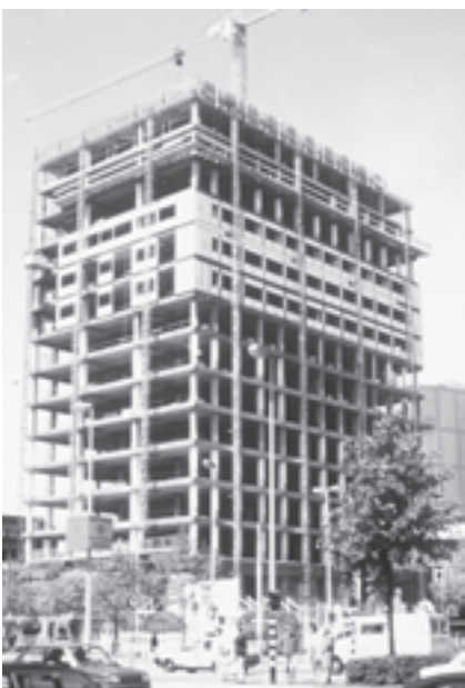
1.1. Voormalig kantoorgebouw van De Stad Rotterdam, Rotterdam. Opname tijdens de renovatie in 1991.
