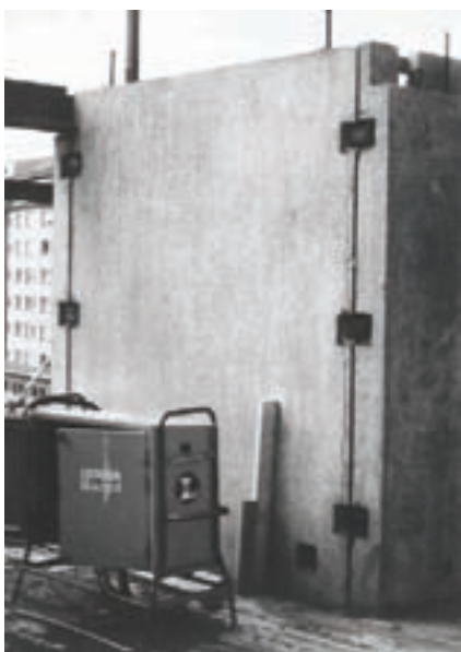
6.8. Geprefabriceerde stabiliteitswanden van beton in het werk aan elkaar gelast.
