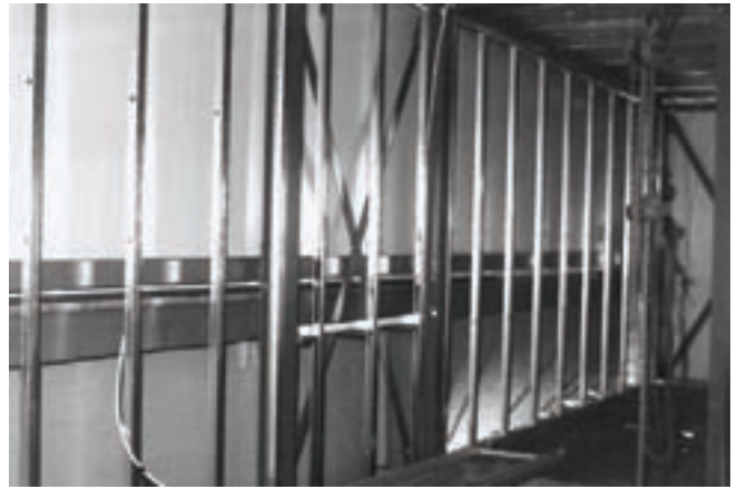
1.11. Kantoorgebouw ZNC, Dintelmond (1992): (a) IFB-ligger (Arbed); (b) metal stud profielen als binnenblad van de buitengevel.
