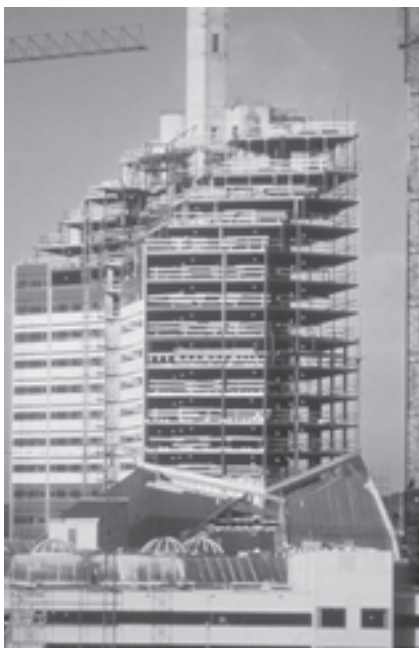
1.7. NSQ-ligger (Nortälje Svets) in (a) kantoorgebouw Lilla Bommen, Göteborg (S) en (b) Wasa Center, Stockholm (S).
