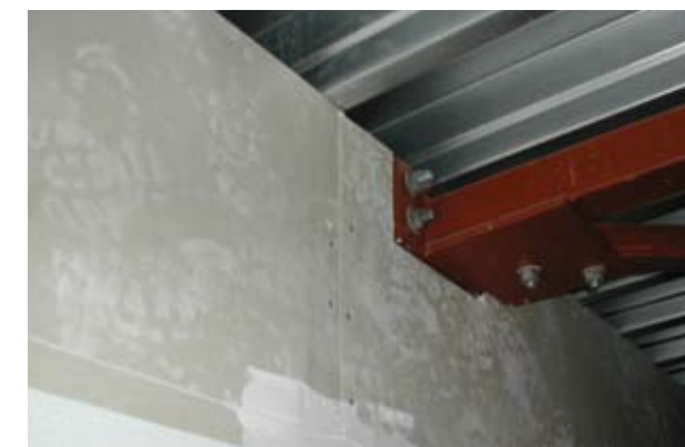
Opening tussen dak en brandwerende wand, geen brandwerende scheiding
