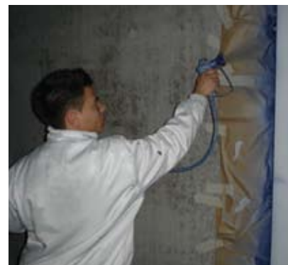
Het opbrengen van brandwerende coating
