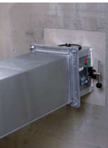
Zorgvuldig afgedichte brandwerende doorvoering
