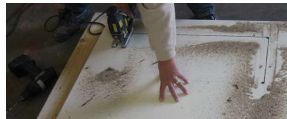
Aanpassing in de bouw: niet aantoonbaar brandwerend
